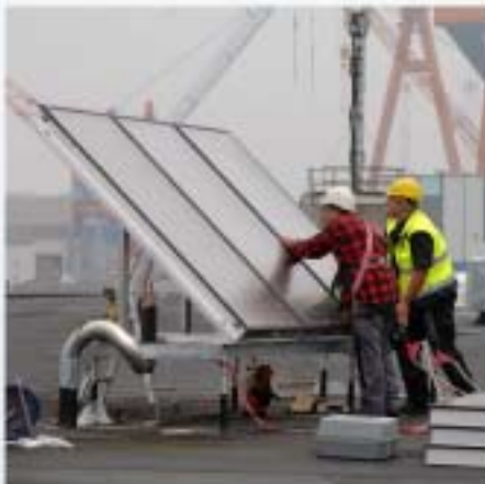
» Montage von Sonnenkollektoren
